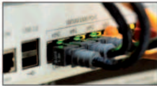
instalación de redes
