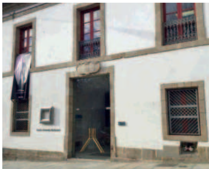
Centro Cultural Torrente Ballester en Ferrol.
