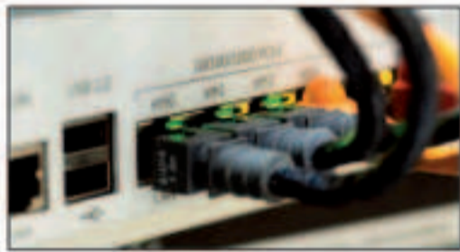
instalación de redes
