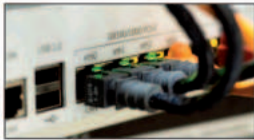
instalación de redes
