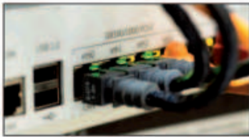
instalación de redes
