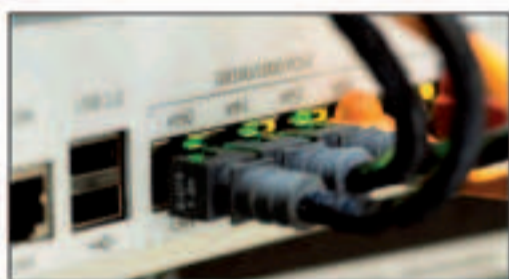
instalación de redes
