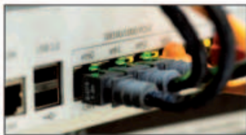
instalación de redes
