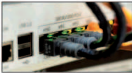
instalación de redes
