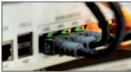
instalación de redes
