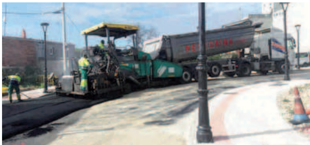
Asfaltado de calles en la zona das Eiras, Meicende.
