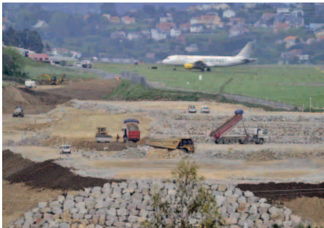
Obras en el aeropuerto de Alvedro, Culleredo.
