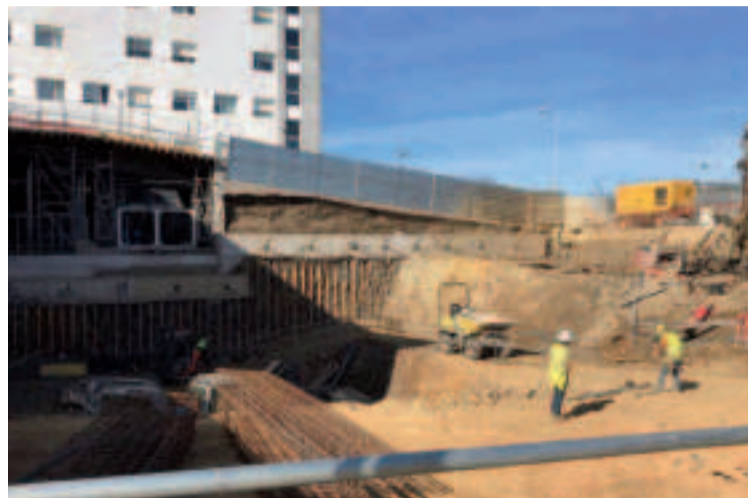
Obras del Hospital Arquitecto Marcide.
