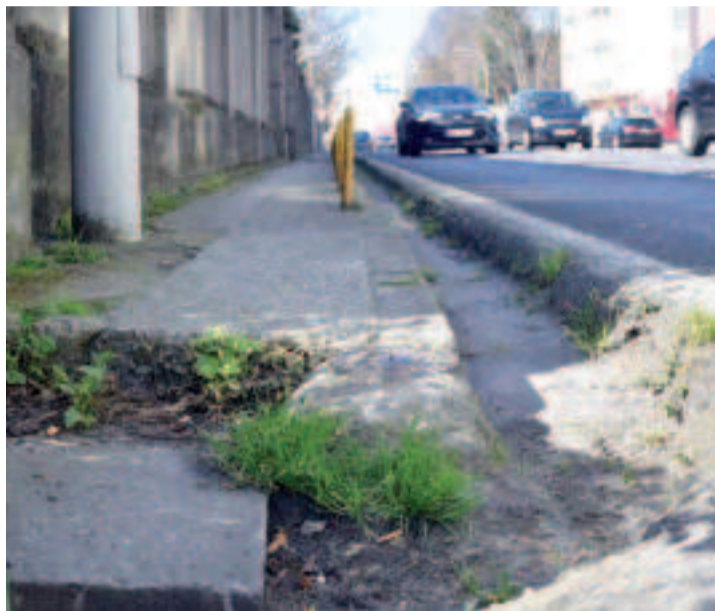
Las aceras presentan importantes socavones y son estrechas para las personas con movilidad reducida.
