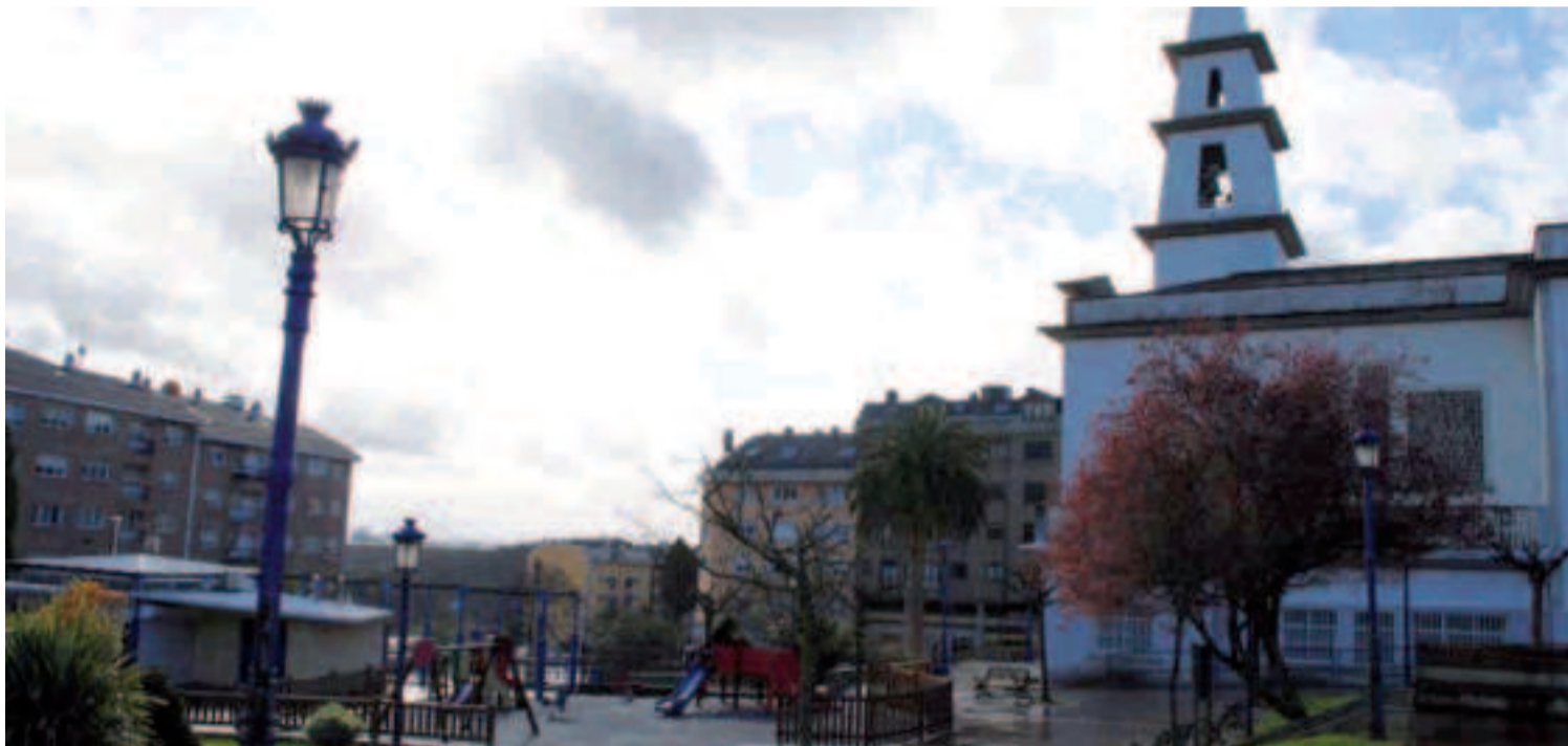
La plaza del entorno de la iglesia se encuentra bastante deteriorada debido a las inclemencias del tiempo.
