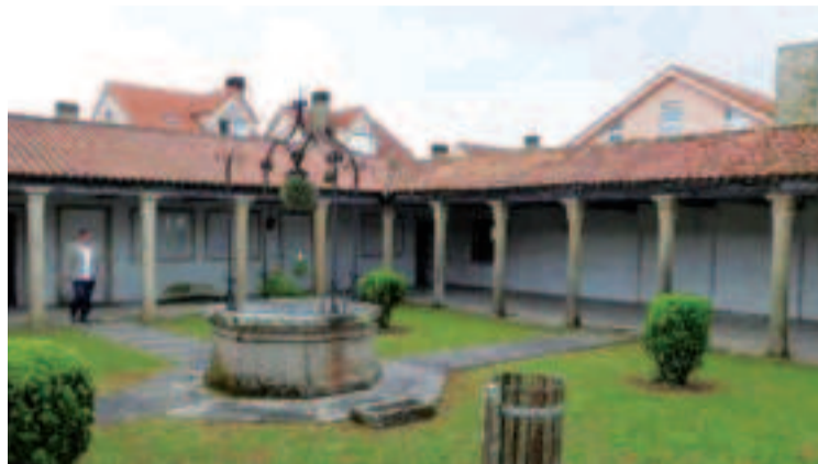
Patio interior del pazo de Arenaza, en Oleiros, rehabilitado por la Diputación para "coworking".
