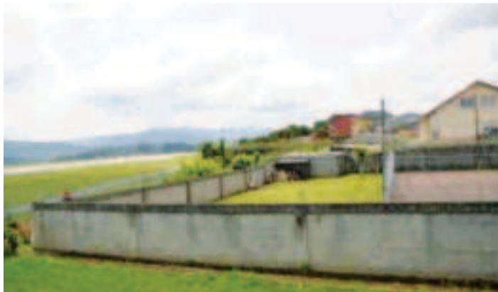
Viviendas afectadas por la actualización del plan director, junto al aeropuerto.
