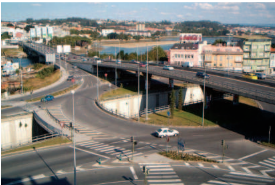
Puente del Pasaje.
