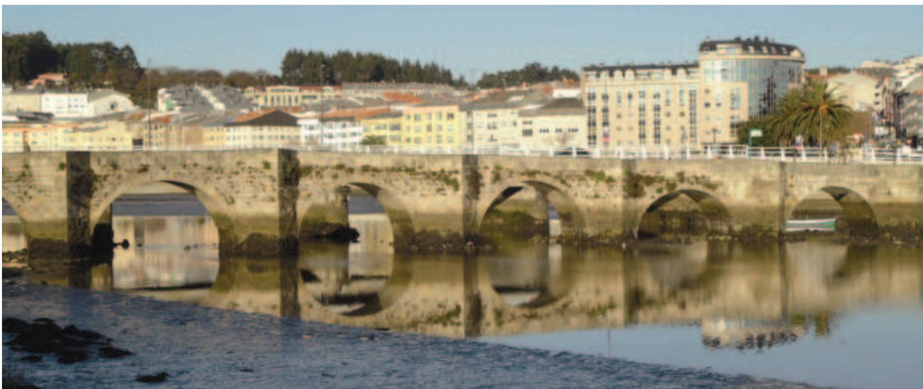
El primer puente sobre la ría de O Burgo, el puente de O Burgo, fue construido hace milenios en la época de los Romanos.
