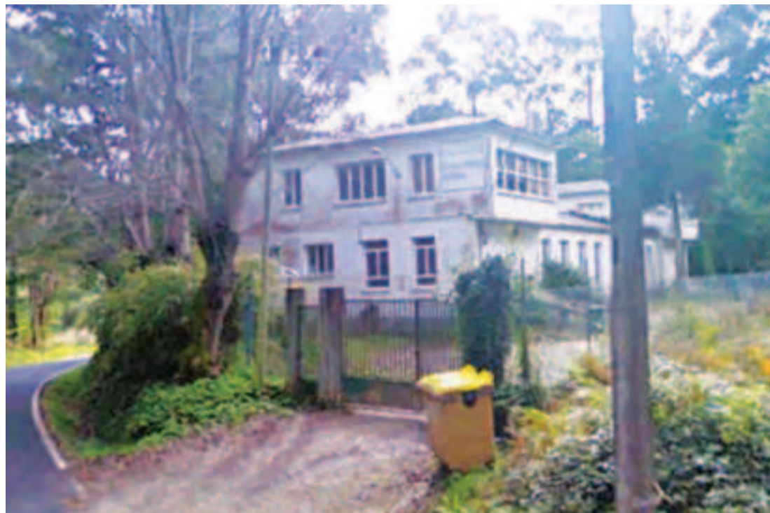
A Deputación e o Concello de Sada destinan 250.000 euros á rehabilitación integral do centro de formación ocupacional de Osedo.
