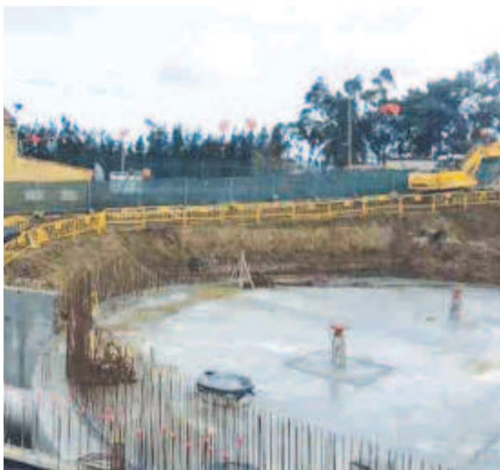
Obras de construcción del depósito de cabecera en Almeiras.
