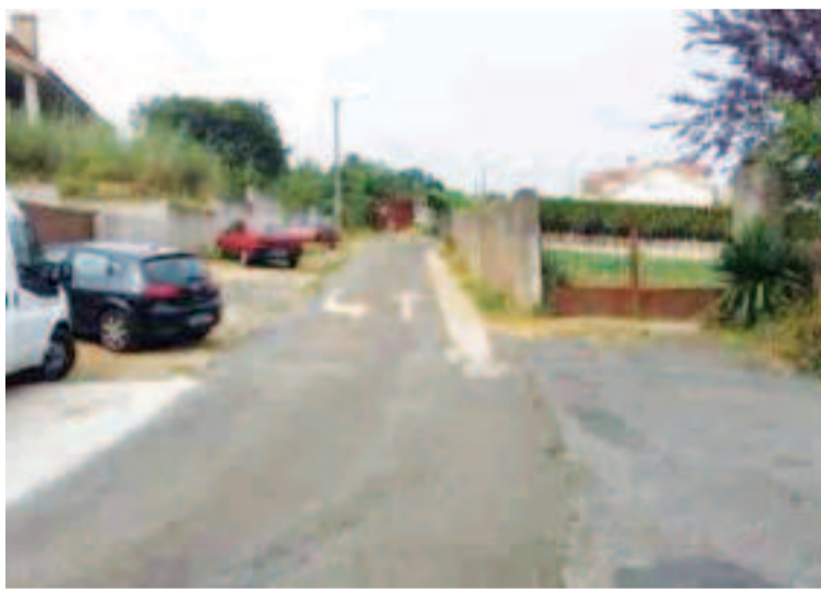
Vista del frente de las viviendas afectadas en la calle Sixto.
