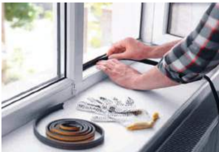
Los burlletes son una solución sencilla y económica para frenar las corrientes de aire en tu hogar.
