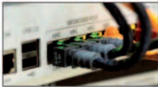
instalación de redes
